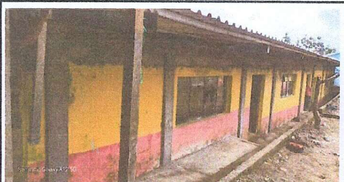
LA IMAGEN MUESTRA QUE LA PARED DE LOS MUROS QUEDA BIN REPELLADO
