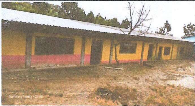
EN ESTA IMAGEN MUESTRA LA REINSTALACION DEL TECHADO
